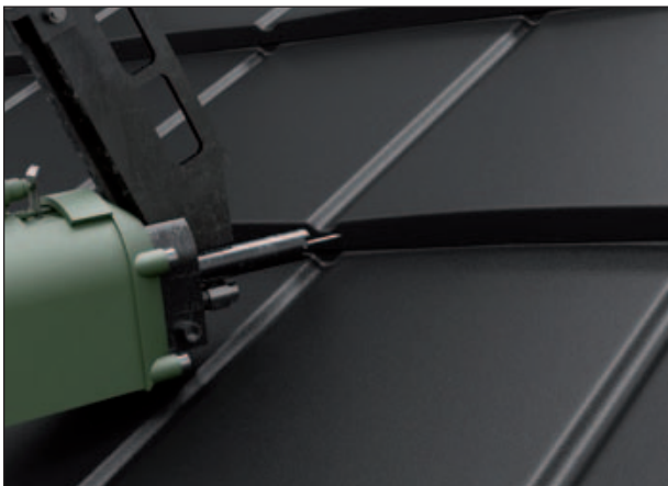
Vzdálenost šroubu od vodící drážky: 15 mm
